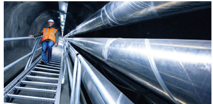
Figura 2.5-10: GIL colocado en pozo con pendiente de 42° (Limberg, Kaprun, Austria)
