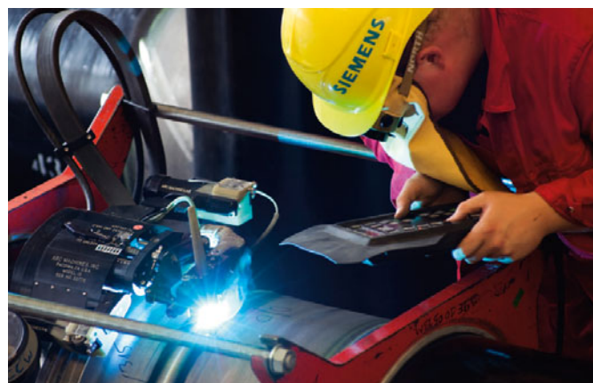
Figura 2.5-5: Soldadura orbital de tubos GIL
