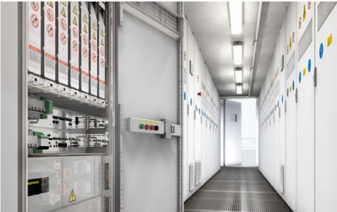
Figura 2.8-4: La integración de los armarios de almacenamiento de energía en un la carcasa teñida garantiza una aplicación especialmente sencilla
