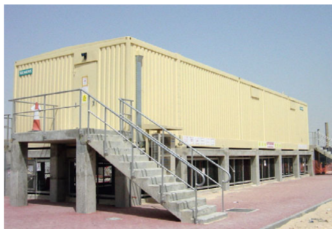
Figura 2.9-5: 3 módulos split SIEHOUSE para Pearl GTL en Qatar, conjuntamente desarrollado por QP y Shell
