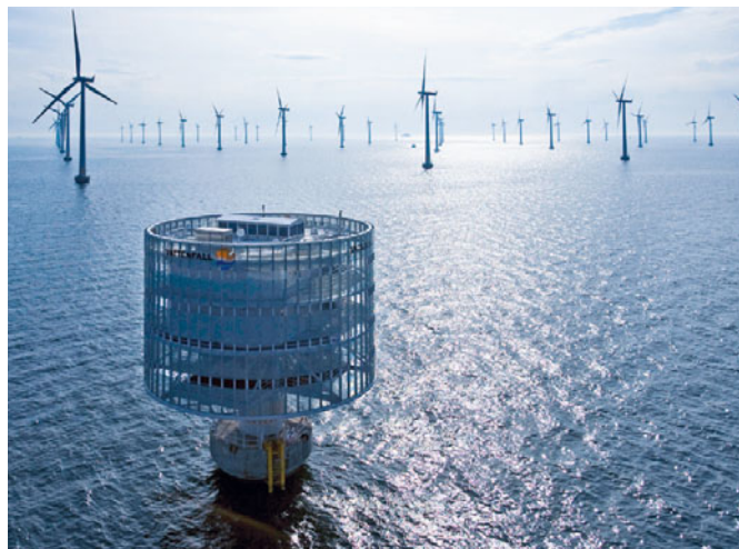
Figura 2.6-4: 2007 Parque eólico marino de 110 MW Lillgrund, Suecia
